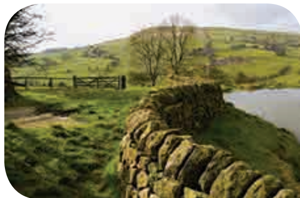
Muretti a secco caratteristici delle campagne inglesi e principali metodi di recinzione dei terreni dopo le Enclosures Acts.
